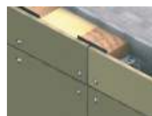
Fibrocemento sobre madera.
