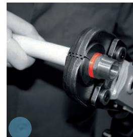
Proceda al prensado: Es muy importante utilizar prensas eléctricas o de baterías, que garanticen una fuerza de empuje de **32 KN/cm<sup>2</sup>**. Es recomendable utilizar solo herramientas homologadas.
