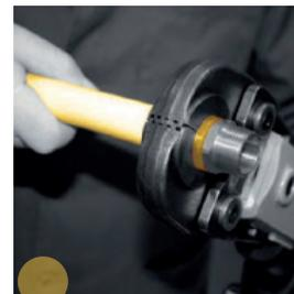
Proceda al prensado: Es muy importante utilizar prensas eléctricas o de baterías, que garanticen una fuerza de empuje de **32 Kn/cm²**. Es recomendable utilizar solo herramientas homologadas.
