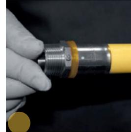
Debe introducirse el accesorio en el tubo hasta su base de manera que el casquillo de acero inoxidable quede unido a la junta plástica anti-electrólisis.
