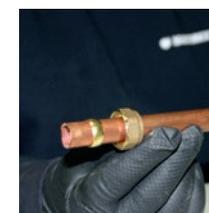
Una vez insertada la tuerca en el tubo colocar a continuación el anillo de retención.
