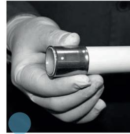
Insertar el casquillo de acero inoxidable en el tubo, en la posición que los orificios de inspección queden situados en el extremo del tubo.
