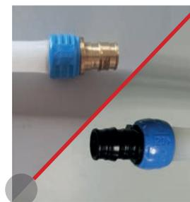
Sacar la herramienta e introducir sin demora el accesorio manteniendo la presión unos segundos hasta que la tubería se contraiga y sujete adecuadamente el accesorio.
