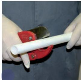
Cortar el tubo perpendicularmente a su longitud, utilizando para ello una herramienta que garantice un corte limpio y preciso.
