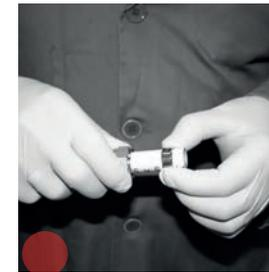
Colocar el anillo de retención del accesorio en el tubo.
