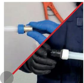
A continuación, se insertará el accesorio en el interior de la tubería. Este paso se debe realizar sin demorarse mucho ya que el tubo se mantiene ensanchado unos segundos hasta que se contrae de nuevo. Por ello este sistema es seguro, fácil y rápido.
