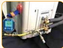
Vacío con vacuómetro VG64-LX
