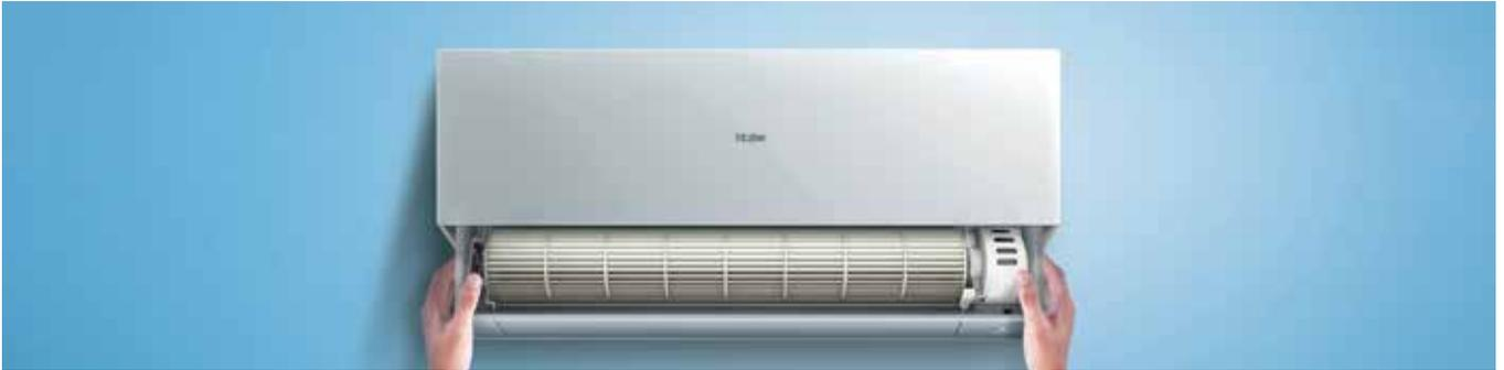
La unidad interior se ha diseñado para hacer posible una limpieza rápida y exhaustiva de los componentes internos del aire acondicionado, así como para simplificar el desmontaje de los componentes principales, como la placa electrónica, el motor y el ventilador. Una limpieza en profundidad garantiza la eliminación de las bacterias, el polvo y los mohos que se van acumulando en el interior de la unidad con el tiempo y el uso.
