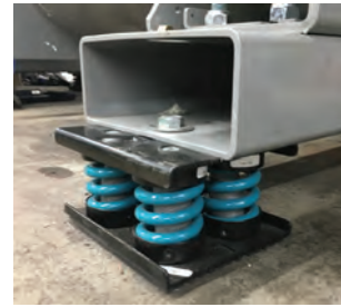
Montaje con alfombra vibroacústica y nivelación
