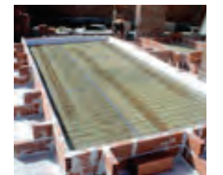
Ejecución de la bancada
