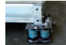
Montaje con alfombra vibroacústica y nivelación
